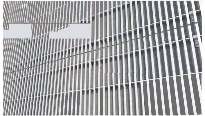
L'installation des panneaux à la structure s'effectue à l'aide des clips du type PP spécialement conçues. Cette solution permet une installation très simple sur pratiquement tous les types de support.
